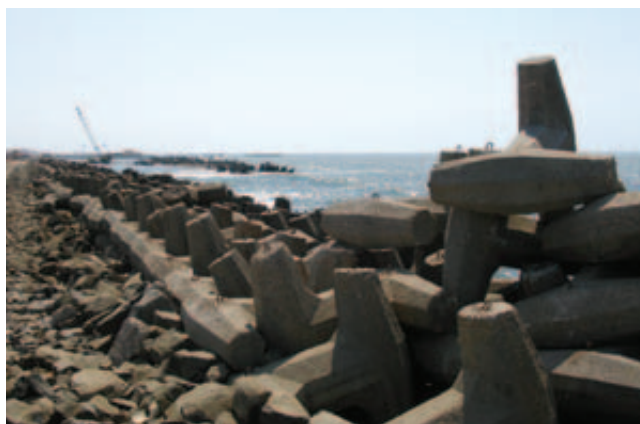
Les mesures d'adaptation massives, comme cet ouvrage longitudinal, entraînent des coûts de construction et d'entretien élevés en raison des dommages causés par les vagues.
