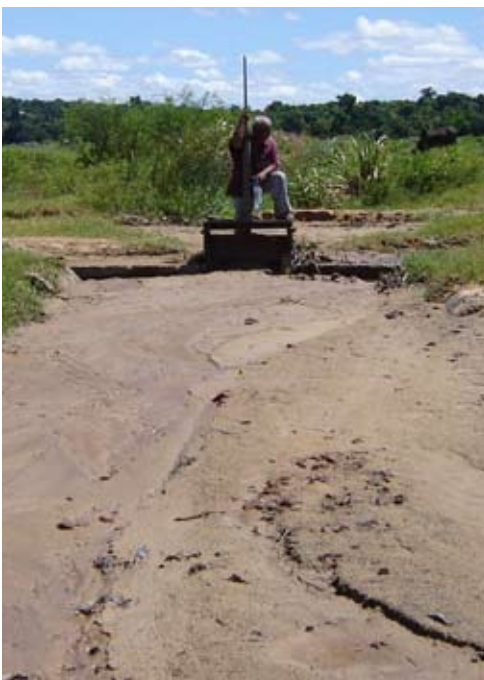
Brèche et ensablement sur le canal principal dit Karambo du barrage de retenue d'Amboromalandy (Photo : Nosy Alizany, ACCA-Madagascar)
